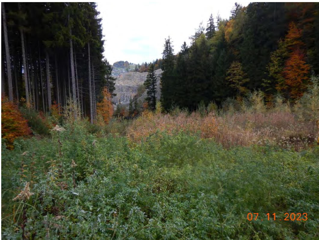
Ansicht Bodenaushubdeponie (Blickrichtung Norden)
